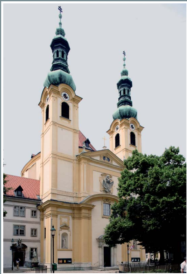
Die Servitenkirche in Wien-Rossau
